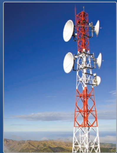
Torre de transmisión (pág. 137)
